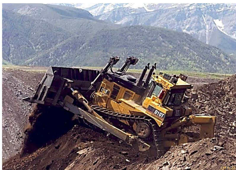
Gambar 6.24 Pengoperasian Bulldozer pada Area Berbahaya
